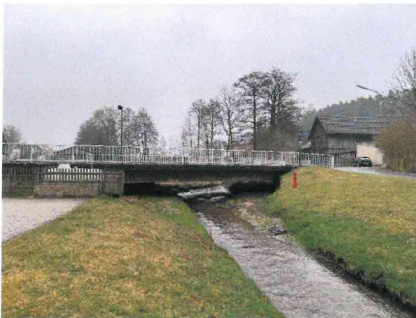
Abbildung 8: Brückenbauwerk direkt am Vorhabensbereich (Reuther Straße)
