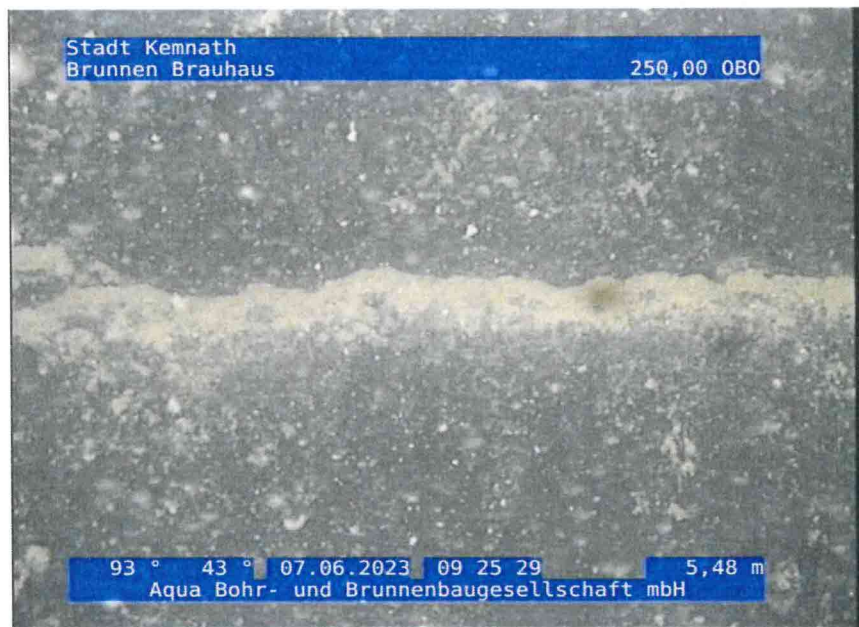
9, 00:06:00, 5.48m Rohrverbindung / Nur 1 Halbschale
