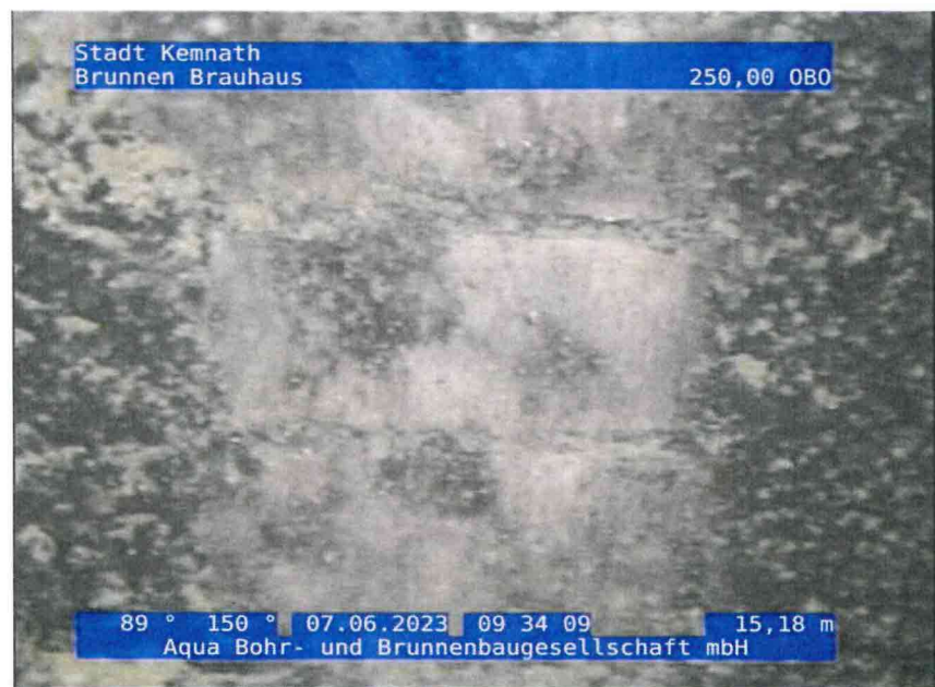
16, 00:14:02, 15.18m Filterschlitz geschlossen
