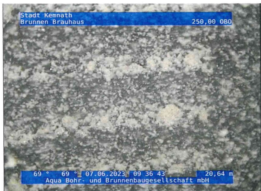
18, 00:16:28, 20.64m Filterschlitz geschlossen
