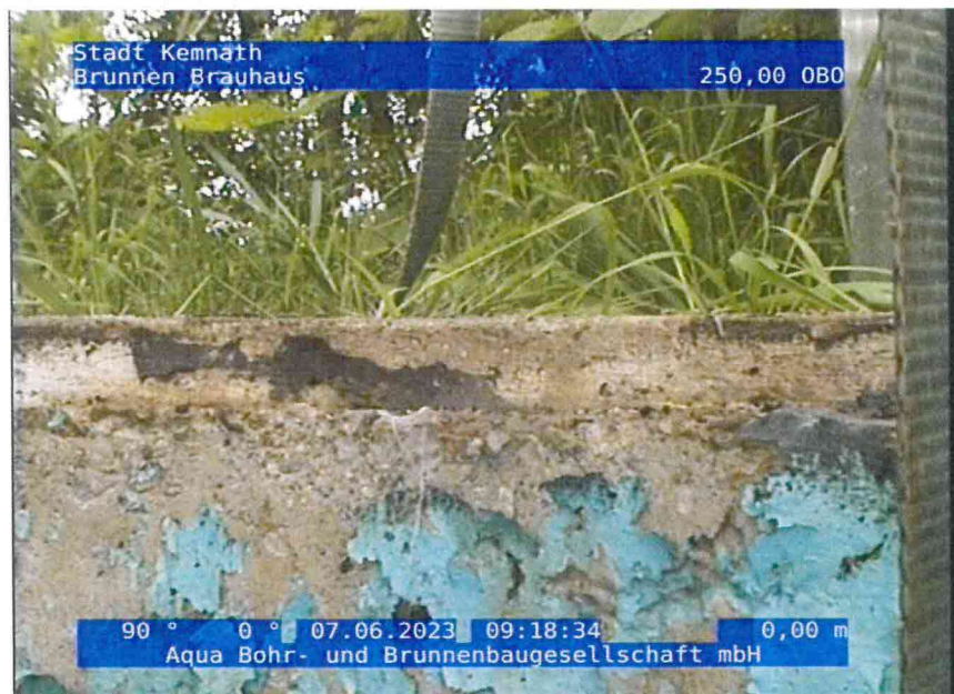
1, 00:00:00, 0.00m Inspektionsanfang / OK Schachtdeckel
