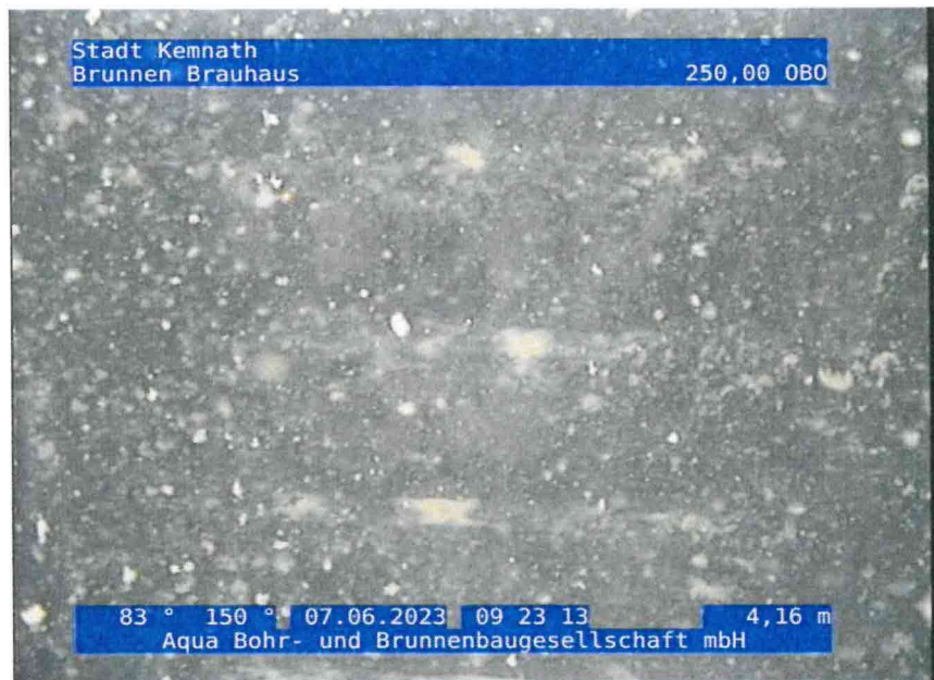
7, 00:04:03, 4.16m Filterschlitz geschlossen
