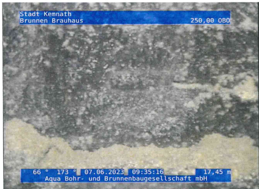
17, 00:15:04, 17.45m Filterschlitz geschlossen
