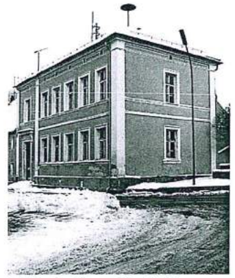
Waldeck; Unterer Markt 63, ehem. Schulhaus
