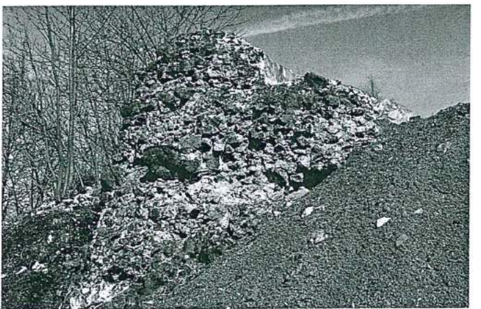
Waldeck; Burgruine, Mauerrest Oberhaus
