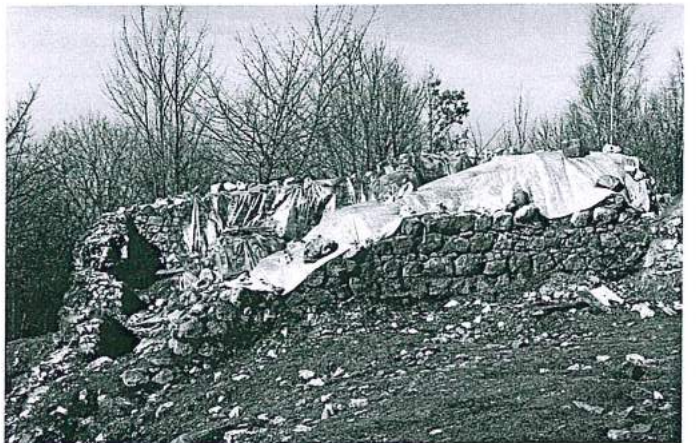
Waldeck; Burgruine, Mauerrest Oberhaus
