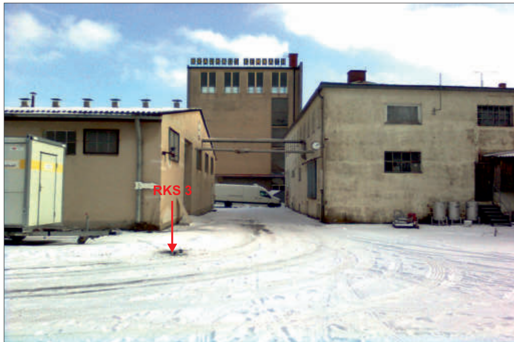
Bild 3: Blick nach Osten auf ehemalige Produktionsgebäude (geradeaus und rechts) und Werkstatt (links); RKS 3 (11.02.2013)
