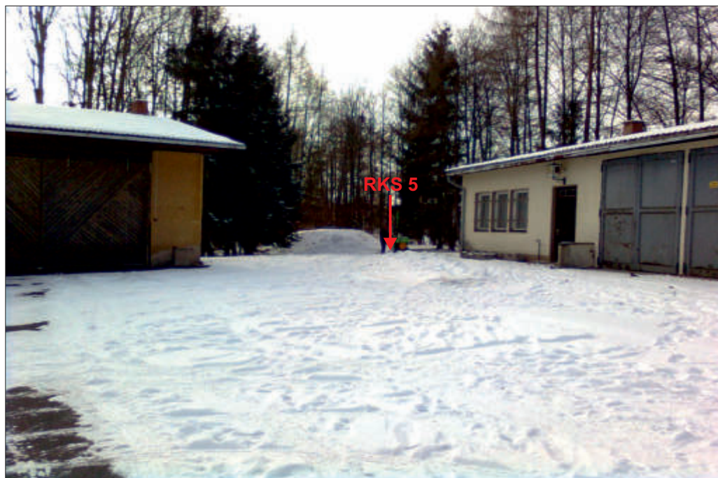
Bild 4: Blick nach Südwesten auf Garage (rechts) und alte Leerguthalle (links) in Richtung RKS 5 (unversiegelter Randbereich) (11.02.2013)
