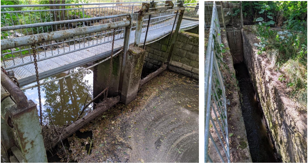
Abbildung 2: Wehranlage am Fallbach, Wehr (links), Zulauf zum Mühlkanal (rechts)
