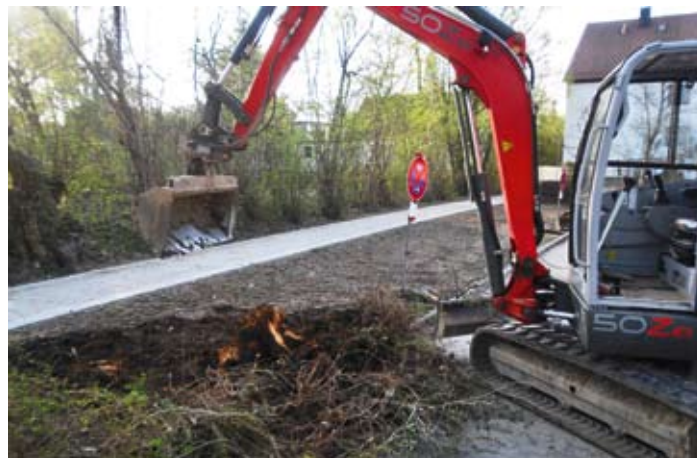
Im Rahmen der Gehölzpflege wurde dafür gesorgt, dass auch das Lichttraumprofil an der Straße wieder stimmt. Gerade für den kommenden Winter ist es wichtig, dass bei Straßen das Lichttraumprofil bei 4,50 Metern liegt und bei Gehwegen bei 2,50 Metern.
