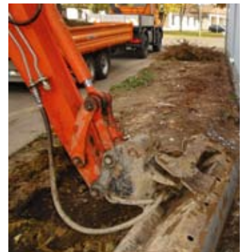
Am Schulhaus ist in Folge der energetischen Sanierungsmaßnahmen eine großflächige Abholzung erfolgt, im Frühjahr soll eine Neugestaltung mit den Mädchen und Jungen der Volksschule erfolgen.
