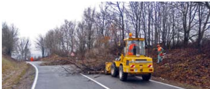
Im Rahmen der Gehölzpflege wurde dafür gesorgt, dass auch das Lichttraumprofil an der Straße wieder stimmt. Gerade für den kommenden Winter ist es wichtig, dass bei Straßen das Lichttraumprofil bei 4,50 Metern liegt und bei Gehwegen bei 2,50 Metern.
