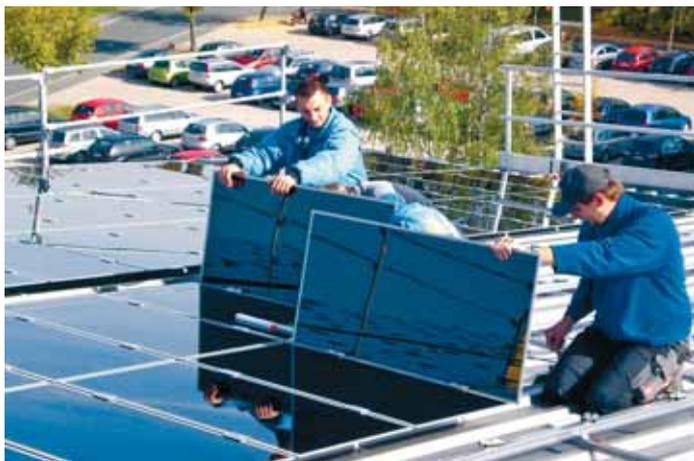
Kräftig gewerkelt wird bereits auf dem Dach der Kemnather Mehrzweckhalle: Die Firma Hempfling Elektro und Solar GmbH aus Prebitz errichtet dort derzeit die Bürger-Photovoltaikanlage. Die fertiggestellte Anlage wird über eine Leistung von 154 kWp verfügen, hierfür werden 2000 Dünnschicht-Modelle aufgebracht. Vorerst besteht die Anteilzeichnungsmöglichkeit ausschließlich für
