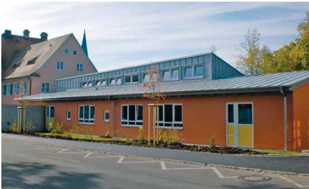
Die Kinderkrippe wurde energieeffizient gebaut durch die Einhaltung der Vorgaben der EnEV (Energieeinsparverordnung), die gesamte Beleuchtung wurde in LED ausgeführt. Die Beheizung erfolgt über Fußbodenheizung mit Brennwerttechnik. Große Fensterflächen sorgen dafür, dass viel natürliches Licht ins Gebäude dringt.
