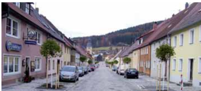
Der sanierte Markt in Waldeck bekommt am 18. Juni den kirchlichen Segen: Gleichzeitig wird das Marktfestival gefeiert. Foto: hl
