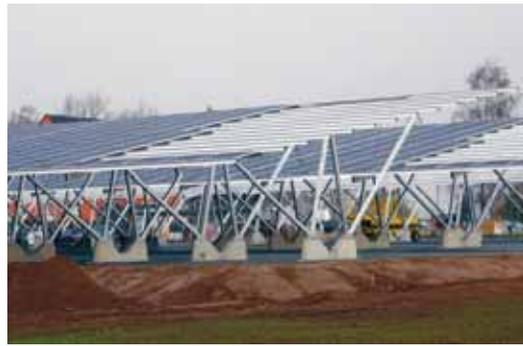
Die Solarcarportanlage unterhalb der Firma Siemens nimmt Gestalt an. Das Projekt liegt voll im Zeitplan. Die Tiefbauarbeiten sind praktisch abgeschlossen. Gleiches gilt für den Aufbau der Carports aus Leichtmetall. Derzeit werden die Solarmodule montiert und verkabelt. Rund 1,5 Millionen Euro investiert die eigens von der Stadt Kemnath gegründete KEM Solarport GmbH in dieses Solarkraftwerk mit Parkplatz.
