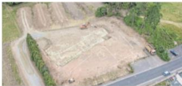
Feinsäuberlich hat der Bagger den Aushub in mehrere, rund 500 Kubikmeter große Aufschüttungen (links oben) für die Beprobung des Erdmaterials getrennt. Die Linien markieren in etwa die Lage der Fundamente des neuen Kinderhauses an der Berndorfer Straße (unten rechts). Bild: luk
