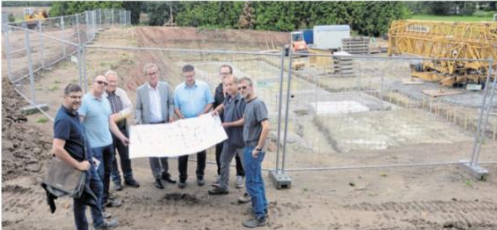
Architekt Günther Lenk (Zweiter von rechts), Bürgermeister Werner Nickl und Bauamtsleiter Roland Sächsel (Mitte von links) stämmen auf der Baustelle mit den beteiligten Firmen das weitere Vorgehen ab. Bild: Gals Schönberger
