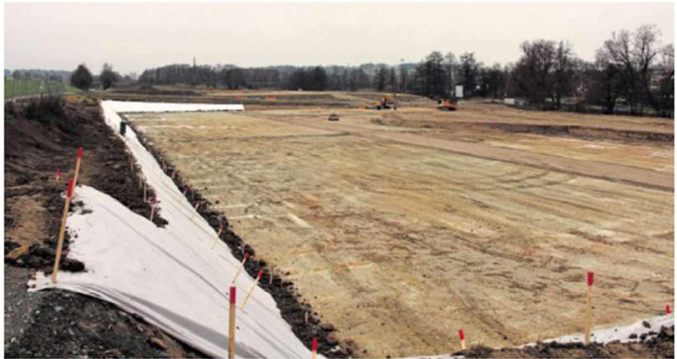
Nicht nur der Landkreis investiert zig Millionen in den Neubau der Kemnather Realschule, auch die Stadt Kemnath trägt massiv zur Realisierung des Projekts bei. Bild: stg
